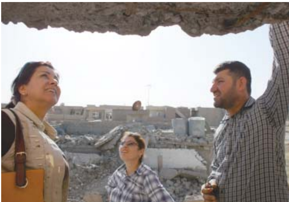
Ekteparet Ihsan og Lara (midten) ser på ruinene av det nybygde huset sitt i Qaraqosh i Irak sammen med Lina Musharbash (t.v.).
